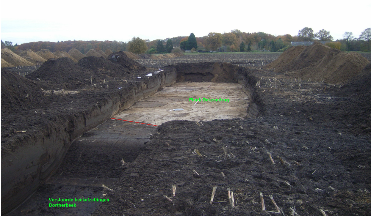
Afb. 4.5 Foto van put 2 met daarin duidelijk zichtbaar het verstoorte bodemprofiel ter plekke van het voormalige beekdal van de Dortherbeek. De verstoringen lopen door tot de flank van de noordelijke dekzandrug, waarop diverse sporen zichtbaar zijn.
